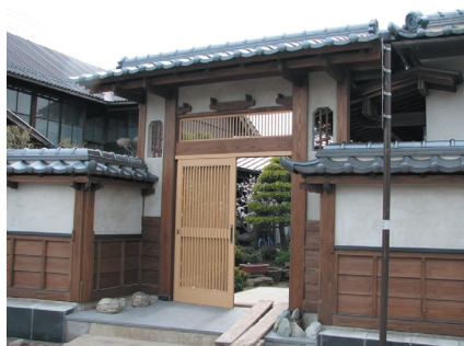
修景された武家屋敷の武家門
